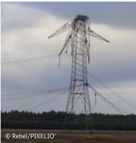
Sturmschaden durch den Orkan Kyrill im Jahr 2007
